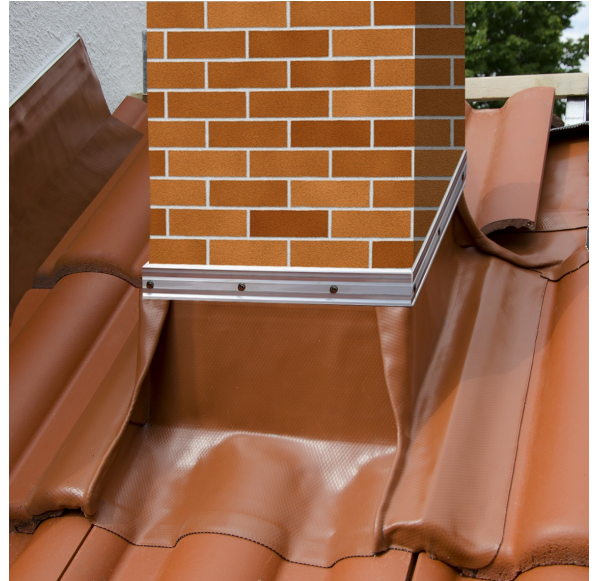
Det går att forma/tillverka alla tänkbara beslag och tätningar på taket med bara sax, penna och tumstock.
